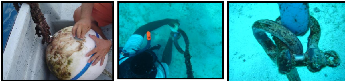
Mantenimiento y limpieza de boyas, verificación de anclaje y pines del sistema de boyado
